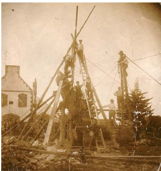
L'érection du menhir a nécessité de gros efforts et l'installation de treuils et d'échafaudages.
